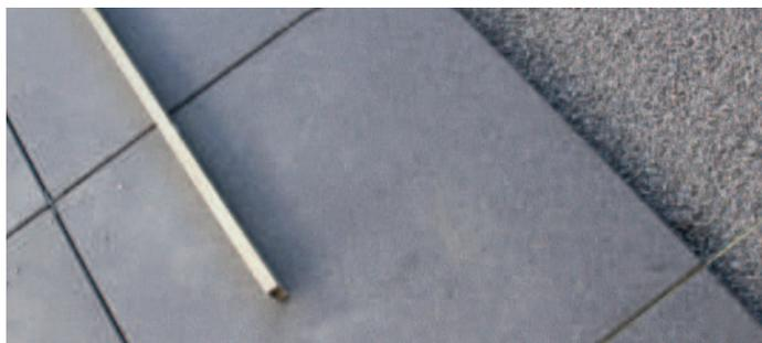
Die Verlegung mit PlattenFix-Lagern ist nur bei zweischichtigen Terrassenplatten möglich. Bei Terrassenplatten ab dem Format 40 x 60 empfehlen wir außerdem zusätzliche Auflagepunkte im Bereich des Plattenmittelpunktes.
